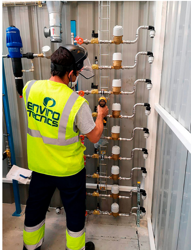
▲ Instalación del manifold para las inyecciones de los diferentes pozos junto al dosificador del oxidante.
