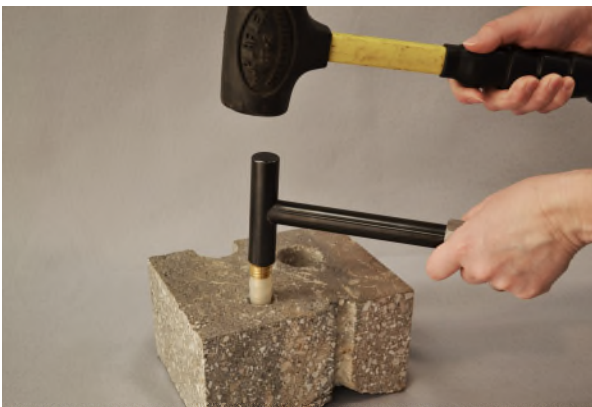
Figura 2. Instalando el FLX-VP®
