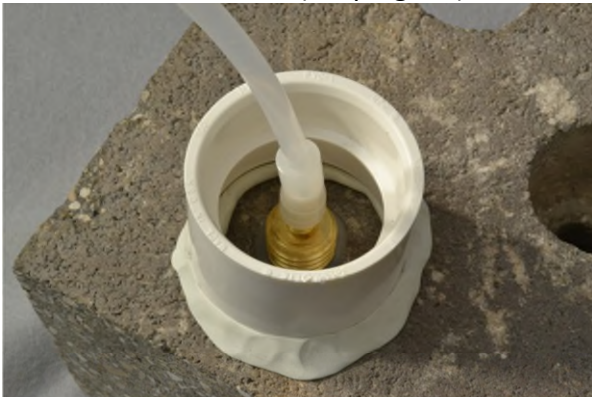
Figura 8. Presa de agua utilizada para la detección de fugas
