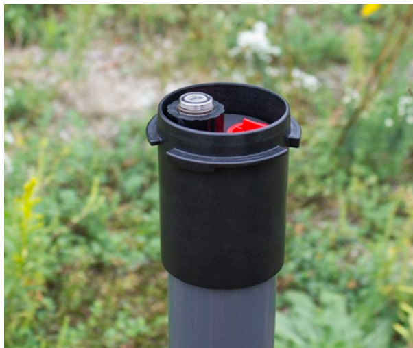
Retire la instalación del levellogger existente
