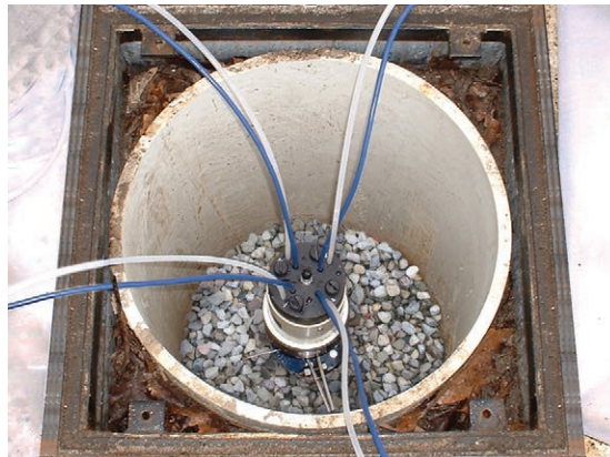
Figura 9-1 Tubería organizada alrededor del cabezal de pozo
