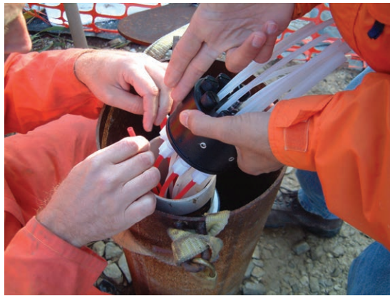
Figura 9-3 Tubería de bomba que se conecta a un cabezal de pozo
