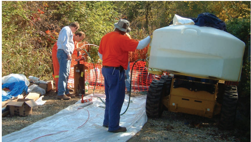
Figura 8-1 Agregado de agua al sistema
