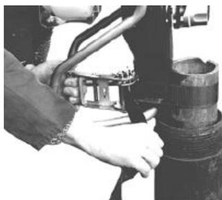
Fijar el PowerPack a la parte sobresaliente del pozo con las cintas proporcionadas. Asegurar, que el PowerPack queda sujeto ajustando las cintas. Una forma de saber que se ha fijado correctamente, sería intentar levantar el PowerPack. En caso afirmativo, repetir el proceso de fijación, pero esta vez con un mejor ajuste.
