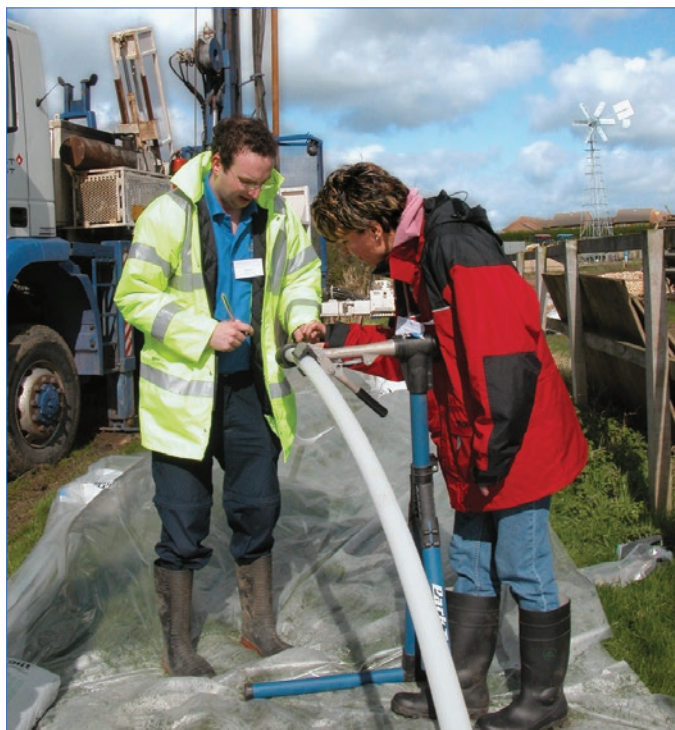
Construcción de los puertos de CMT de 7 canales en Silsoe, Inglaterra
